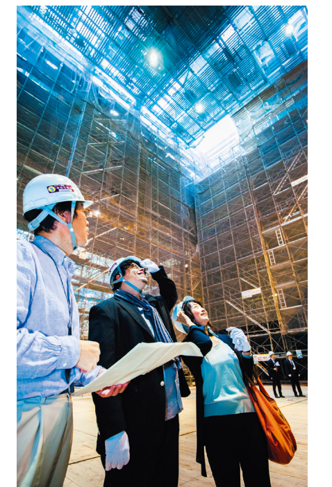
劇場の建設現場を視察。ステージを興味深く見上げる。
