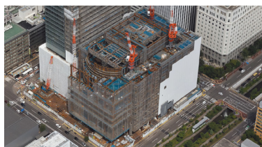
2017年6月27日の建設状況。 劇場内の鉄骨が整ったところ。
