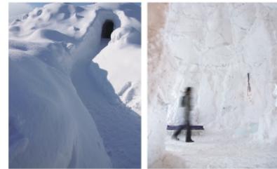
西山仁《Snow Dome》2008年 西山仁と地元アーティスト達によって、柱のない高さ約5mの雪のドームを木の構造体を入れることで実現。内部にカフェ、展示空間を設けた。
